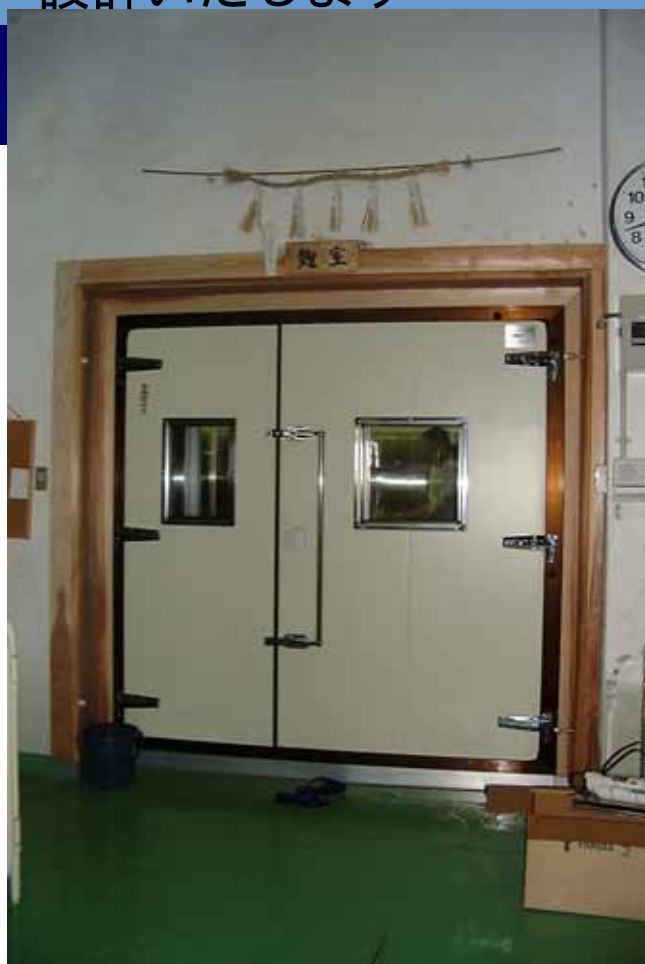
既設の室もスッキリ変身
